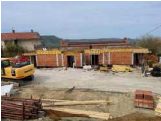
Stanovanjsko naselje Marezige- Gradnja hiš ter dostopne ceste s komunalno infrastrukturo (glavni pogodbeni partner)
