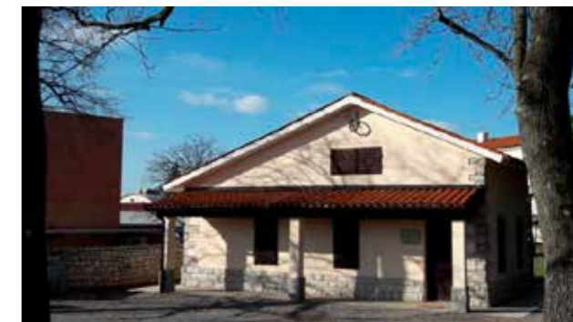
8. Obnova objekta tabornikov v Sežani – streha in fasada
