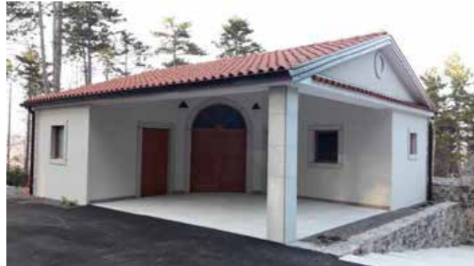
4. Poslovilna vežica TAbor – novogradnja
