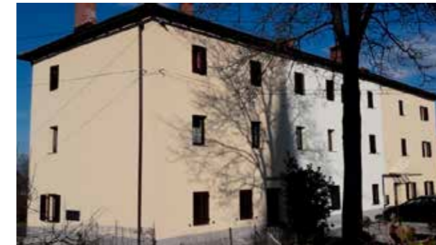
7. Energetska sanacija večstanovanjskega objekta Sejmiška6 in 8 - streha in fasada
