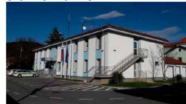
10. Energetska sanacija policijske postaje v Sežani – streha in fasada
