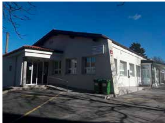
5. Energetska sanacija ambulante in lekarne v Divači – streha in fasada.
