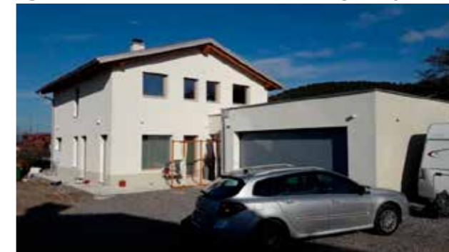
9. Stanovanjska hiša z garažo Bužan v Sežani – novogradnja
